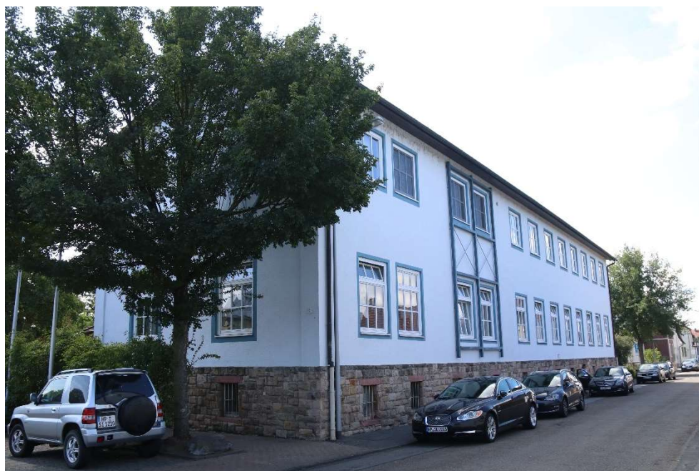
Außenansicht von Westen (Friedensstraße)
